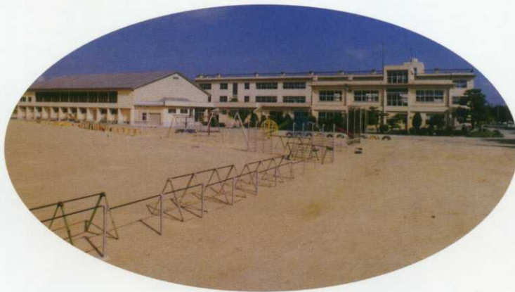
グラウンド側から見た旧校舎
