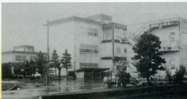
S60.11月 前庭北側進入路新設
