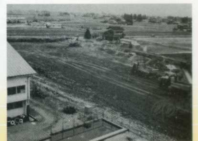
H1.2月 グラウンド拡張 工事着工
